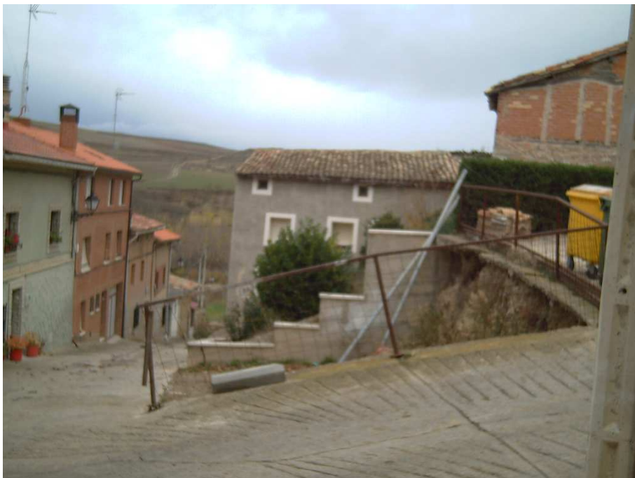
VISTA DE LA CALLE RIO
